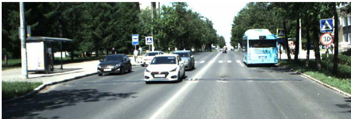
Рисунок 1.6.3.1 – Нарушение места установки ИН (п. 6.8.1 ГОСТ 50597-2017),
