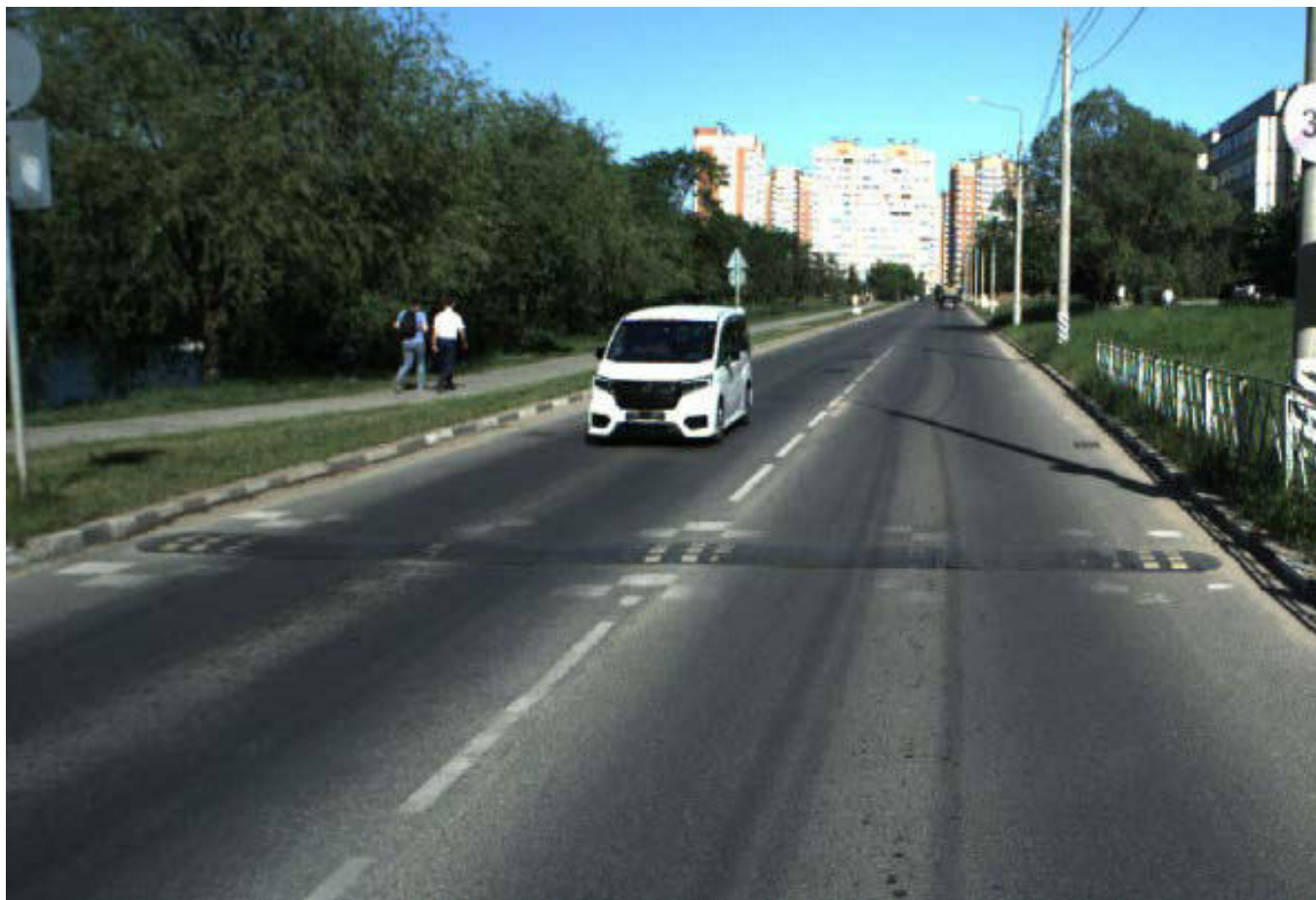
Рисунок 1.6.2.4 – Износ разметки (п. 6.3.2 ГОСТ 50597-2017), ул. Белкинская, 21
