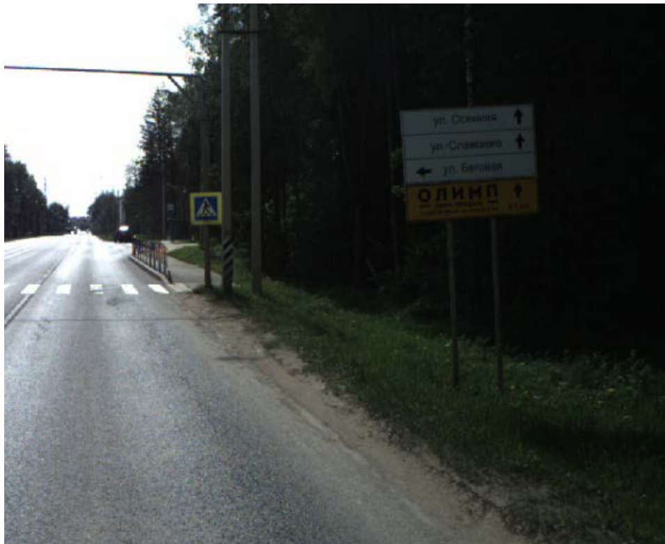
Рисунок 1.6.1.4 – Некорректное исполнение знака индивидуального проектирования (п. 4.9 ГОСТ Р 52290-2004), ул. Борисоглебская, напротив остановки «Экодолье-Северный въезд»
